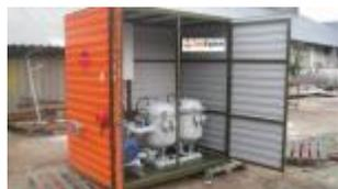
Агрегаты фильтрации топлива (АФТ)
